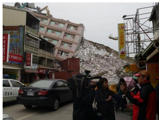
圖 2-4.17 臺南市新化區京城銀行，地震後傾斜，不久即展開拆除，無法確認是否局部沉陷。
