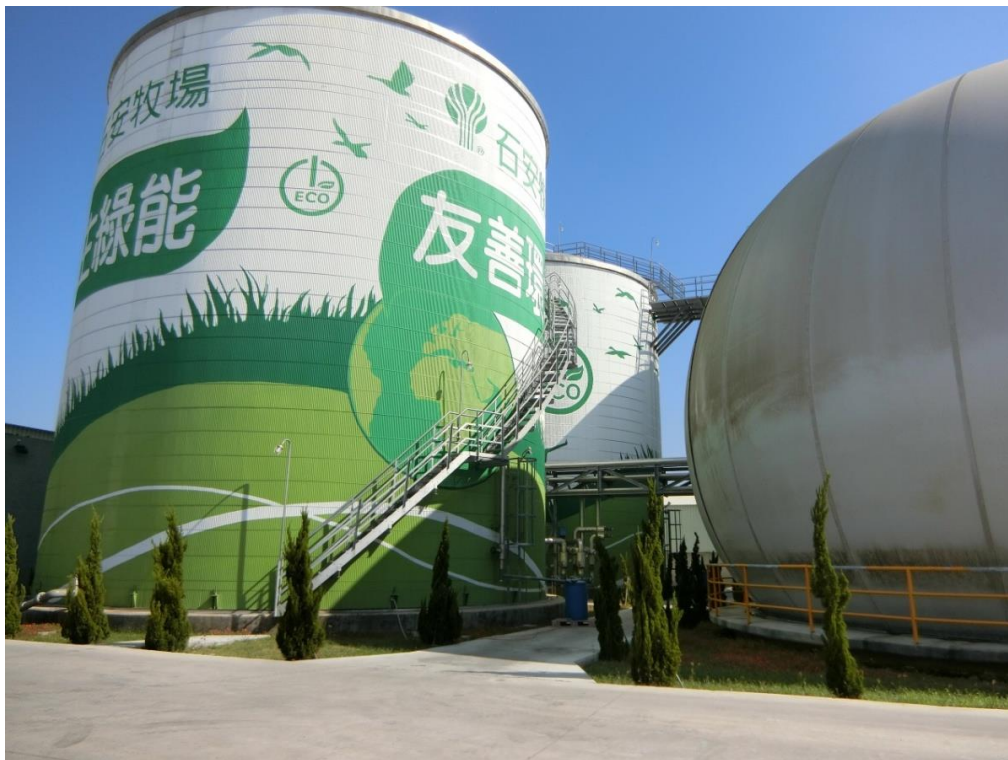
圖 11. 高雄石安牧場消化槽實景
