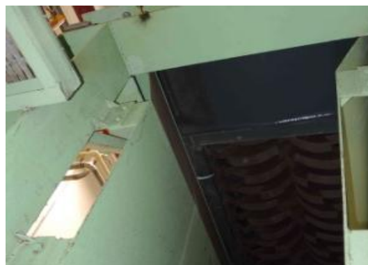
巨大破碎機現況
