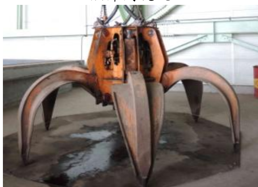
垃圾吊車現況
