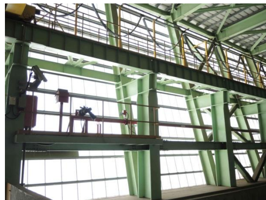
貯坑水泡及消防系統
