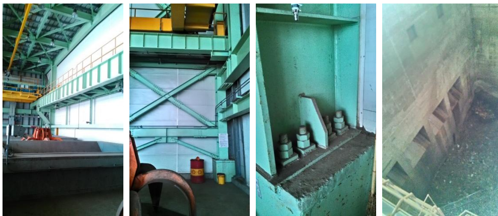
圖 4.3.1-3 臺東廠垃圾貯存區結構現況照片
