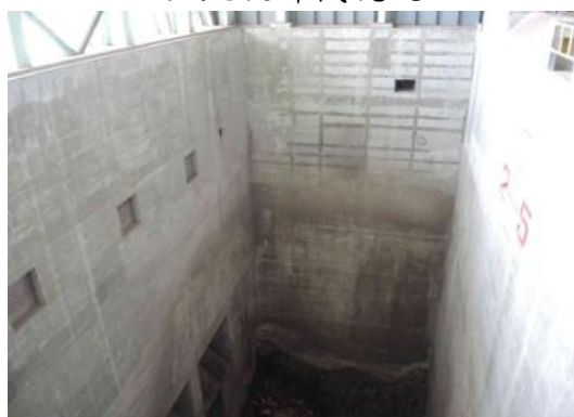
垃圾貯坑現況
