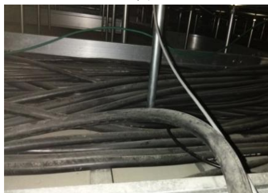
高架地板下纜線佈設
