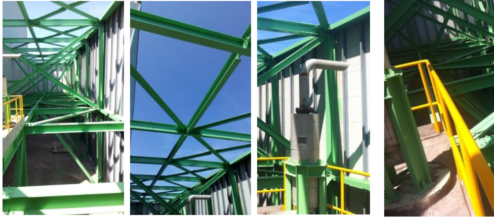
圖 4.3.1-6 臺東廠氣冷式冷凝器區結構現況照片
