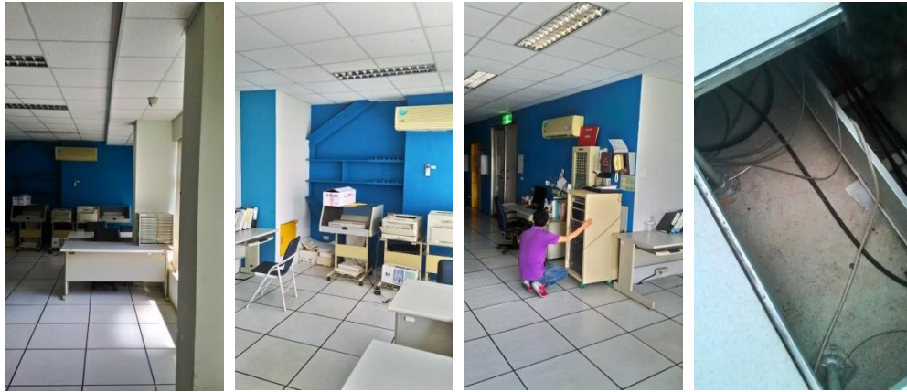
圖 4.3.1-1 臺東廠中控室結構現況照片
