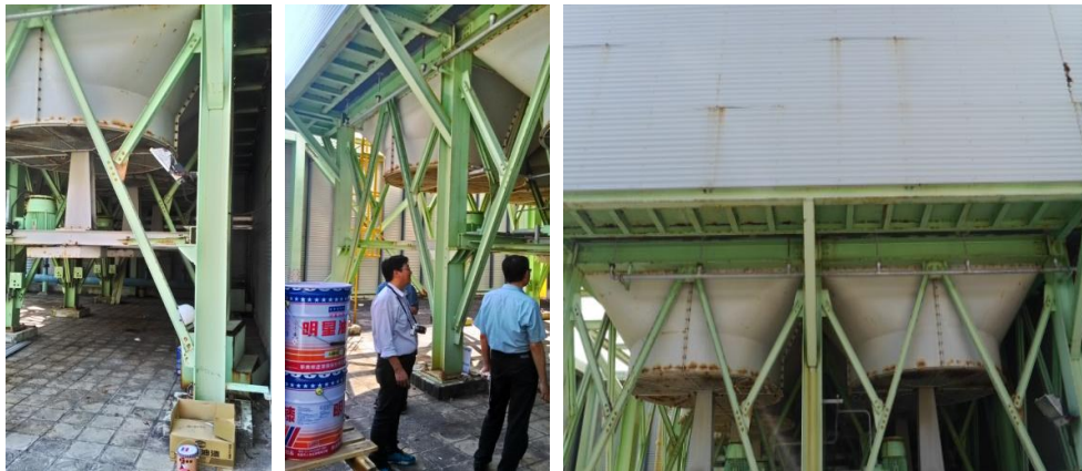
圖 4.3.1-7 臺東廠製程冷卻區結構現況照片
